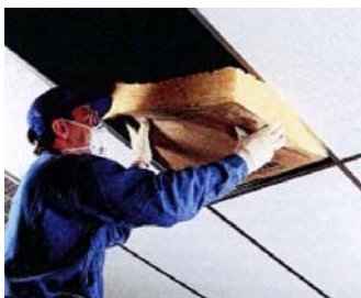
تصویر ۲۱: عایق‌کاری جداره‌های ساختمانی
