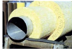
تصویر ۱۴: عایقکاری لوله‌های آبگرم
