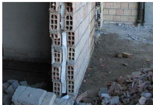
شکل ۴. نمونه ای از اجرای عایق حرارتی دیوار در منطقه ۲ تهران
