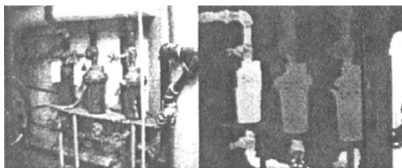
شکل ۶- نشتی Steam Trap
